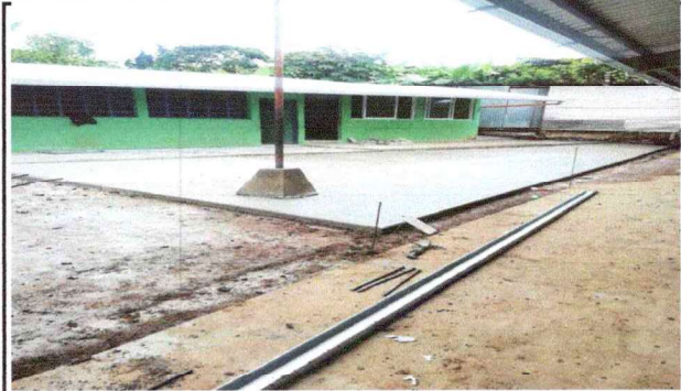
Foto 2: SUSTITUCIÓN LOSA DE PATIO INCLUYE FUNDICIÓN BASE Y ACABADO
