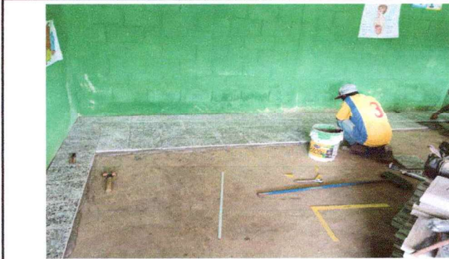
Foto 1: SUSTITUCIÓN PISO DE GRANITO (INCLUYE BASE CON MEZCLÓN)
