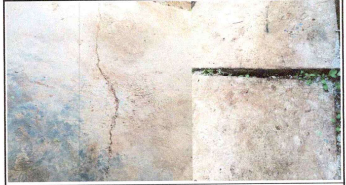
FOTO 2: SUSTITUCIÓN LOSA DE PATIO INCLUYE BASE FUNDICION Y ACABADO
