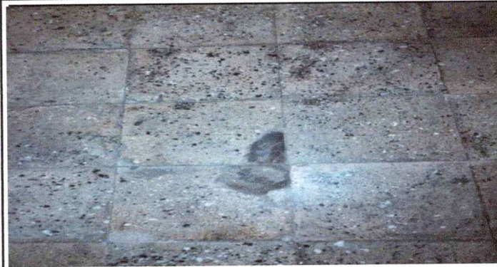
Foto1: SUSTITUCIÓN PISO DE GRANITO (INCLUYE BASE CON MEZCLON)
