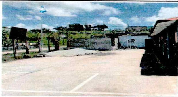
FOTO 1: SUSTITUCIÓN DE LOSA DE PATIO INCLUYE BASE, FUNDICIÓN Y ACABADO ( SE COLOCARA 1 CAPA DE 20CM DE BALASTO PARA EVITAR INUNDACIONES )
