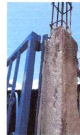
Foto 3.1: Se tallarán 13 columnas que se encuentran en muro perimetral
