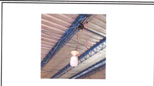
Foto 6: Se reparará sistema electrico y se colocaran bombillas
