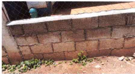
Foto 3: Se realizara repello en paredes de muro perimetral
