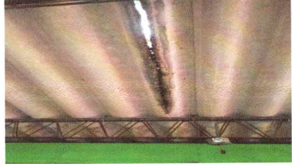
Foto 2: PUERTAS. SE REFORZARÁ LA ESTRUCTURA DE TECHO
