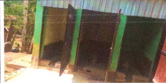
Foto 4: SE REPARARÁ EL ÁREA DE LOS BAÑOS.
