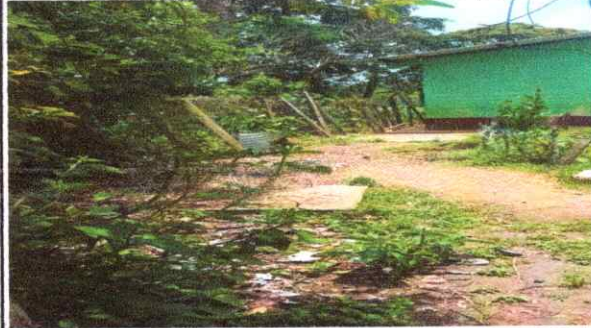
Foto 6: REPARACION DE MURO PERIMETRAL
