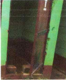
Foto 3: SE SUSTITUIRAN LOS SANITARIOS
