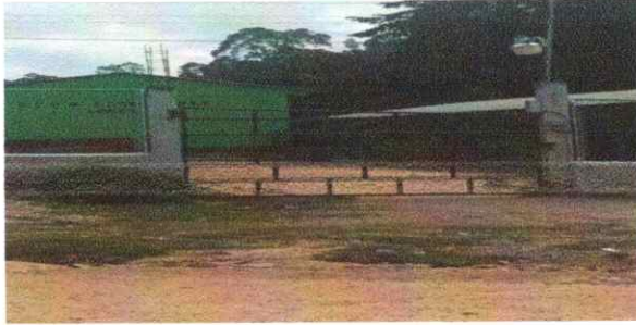
Foto 5: SUSTITUCION DE PORTON
