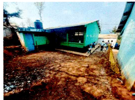
Foto 6: REPARACIÓN DE CUNETETA DE CONCRETO
