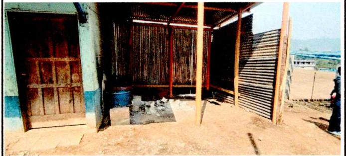
FOTO 2: REPARACION DE MODULO DE COCINA Y PINTURA
