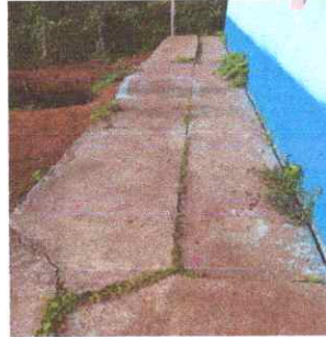
Foto 2: LOSA DE PATIO
