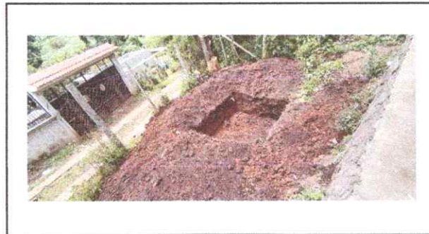
Foto 4: SUSTITUCION DE RED DE DRENAJE (FOSA SEPTICA)
