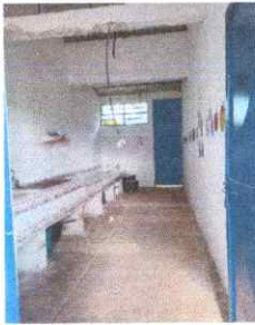
Foto 1: REPACION DE DE REPELLO Y CERNIDO DE PAREDES
