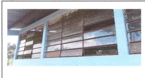
Foto 1: SUSTITUCION DE VIDRIOS MEDIDAS TIPICAS
