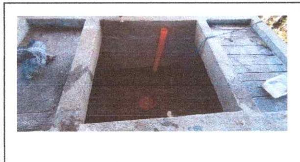
Foto 3: SUSTITUCION DE AZUJELO (FILTRACION DE PILA)
