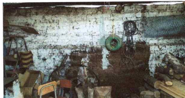
Foto 4: SUSTITUCION DE REPELLO Y CERNIDO
