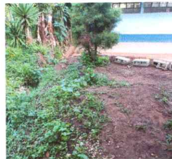
Foto 6: REPARACION Y MANTENIMIENTO A FOSA SEPTICA
