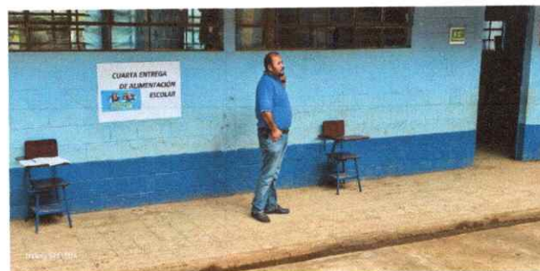
Foto 6: PINTURAS EN MUROS EXTERIORES
