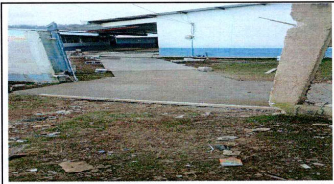
Foto 1: Losa de Patio
