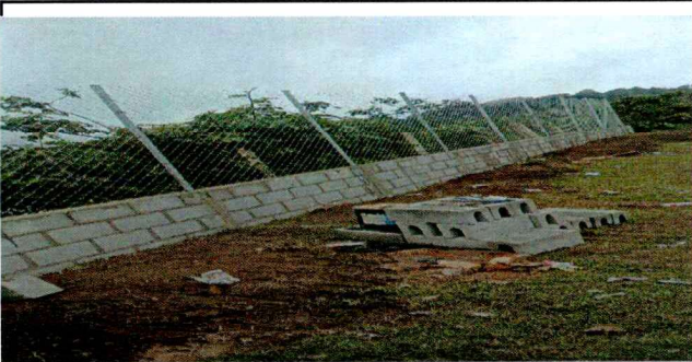
Foto 5: Cerco o muro perimetral
