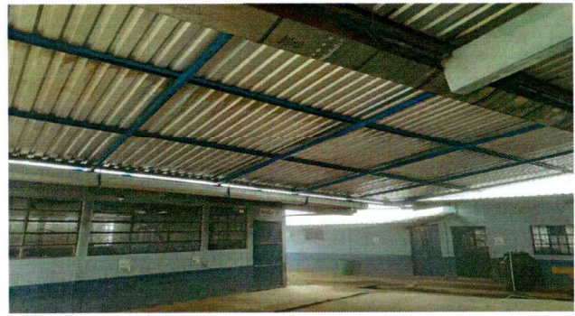
Foto 2: Estructura de Techo
