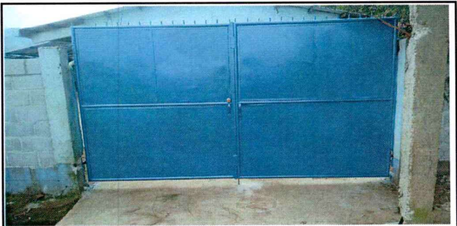
Foto 6: Mantenimiento a portones
