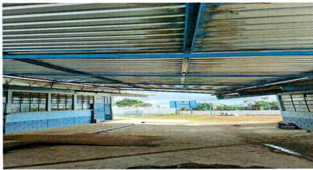
Foto1: Cubierta de Lámina
