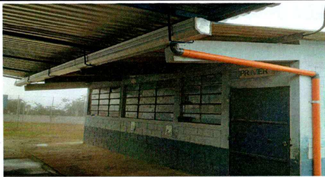
Foto 3: Canales y bajadas de agua pluvial
