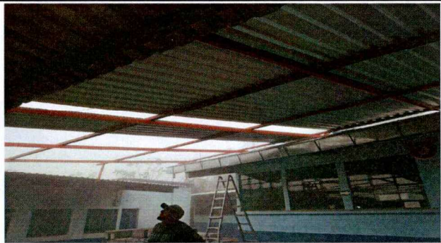
Foto 1: Cubierta de Lámina
