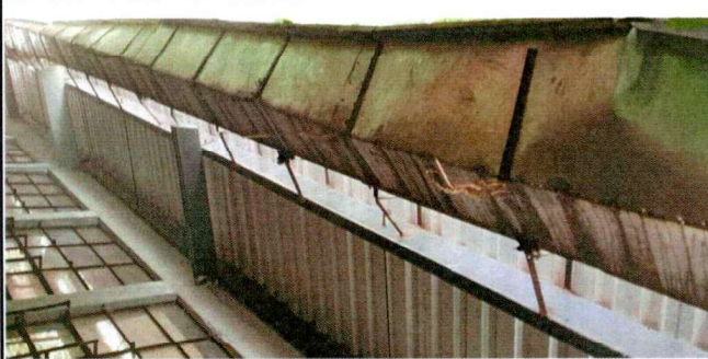
Foto 3: Canales y bajadas de agua Pluvial
