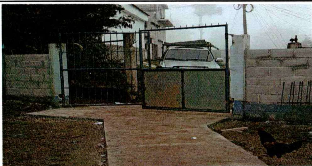
Foto 5: Mantenimiento a portones
