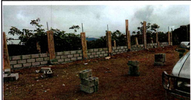
Foto 6: Cerco o muro perimetral
