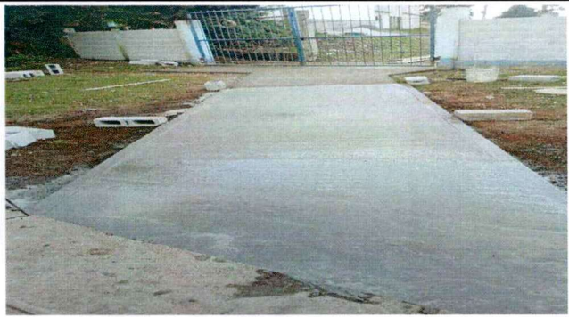
Foto7: Losa de patio
