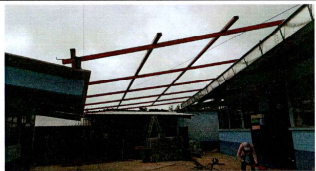
Foto 2: Estructura de Techo
