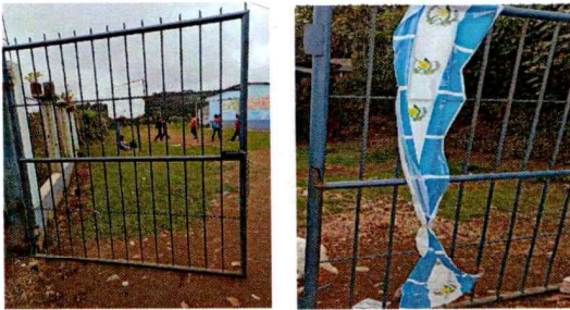
Foto: Mantenimiento de portones
