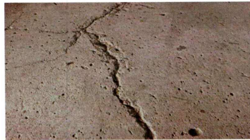
Foto: Losa de patio
