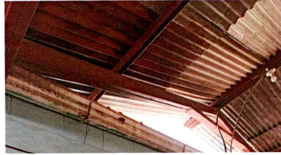
FOTO 2: Estructura de techo
