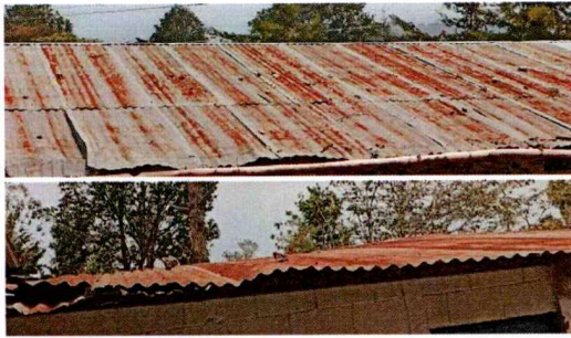
Foto: Cubierta de lamina
