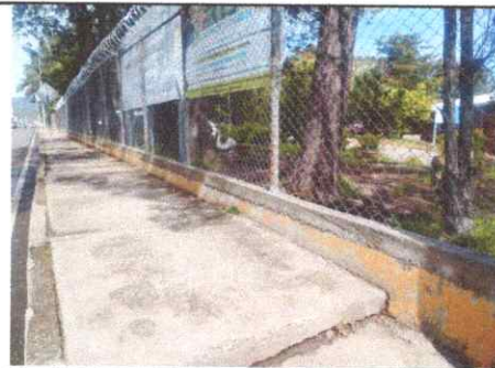
Foto 4: SUSTITUCIÓN DE PINTURA BASE ACEITE (ZOCALO) FRENTE DEL ESTABLECIMIENTO, HACIA EL CAMPO DE FUTBOL 175 MTS2.
