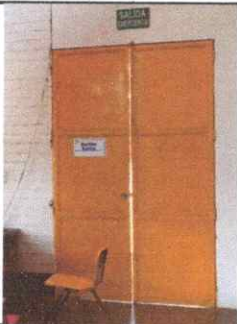
Foto 17: REPARACIÓN Y MANTENIMIENTO A PORTONES SALÓN DE USOS MÚLTIPLES (Sustitución chapa, pasadores, nivelación de portón)
