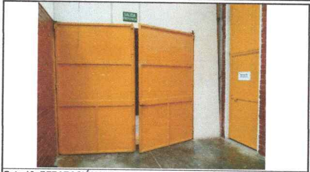
Foto 19: REPARACIÓN Y MANTENIMIENTO A PORTONES SALÓN DE USOS MÚLTIPLES (Sustitución chapa, pasadores, nivelación de portón)
