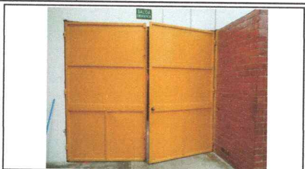
Foto 20: REPARACIÓN Y MANTENIMIENTO A PORTONES SALÓN DE USOS MÚLTIPLES (Sustitución chapa, pasadores, nivelación de portón)
