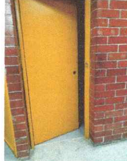
Foto 14: SUSTITUCIÓN DE PUERTAS DEL ÁREA ADMINISTRATIVA
