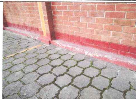
Foto 8: SUSTITUCIÓN DE PINTURA BASE ACEITE (ZOCALO) TALLERES DE CARPINTERÍA Y METALES FRENTE A PARQUEO 40 MTS2
