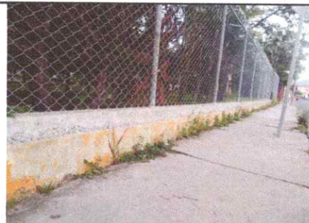
Foto 6: SUSTITUCIÓN DE PINTURA BASE ACEITE (ZOCALO) FRENTE DEL ESTABLECIMIENTO, HACIA MEGAFERRO 75 MTS2.
