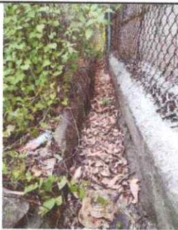
Foto 3: SUSTITUCIÓN DE CUNETA DE CONCRETO
