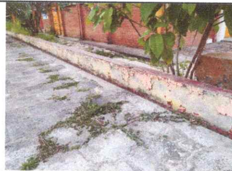
Foto 10: SUSTITUCIÓN DE PINTURA BASE ACEITE (ZOCALO) FRENTE AL PATIO DE FORMACIÓN 60 MTS2
