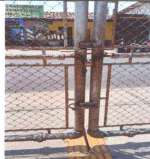
Foto 16: REPARACIÓN Y MANTENIMIENTO A PORTÓN ENTRADA PEATONAL
