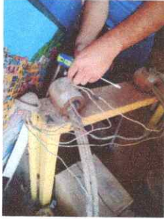
Foto1: SUSTITUCIÓN DE TRANSFORMADORES DE CORRIENTE TOROIDAL ABB DE 400/5 BIL 10KV CLASE 0,5
