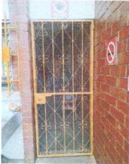
Foto 13: SUSTITUCIÓN DE PUERTAS EN DIRECCIÓN, SUBDIRECCIÓN Y SECRETARÍA
