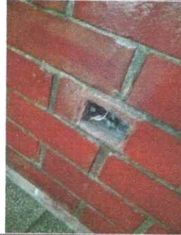
Foto 2: SUSTITUCIÓN DE TOMACORRIENTES EN SALONES DE CLASES
