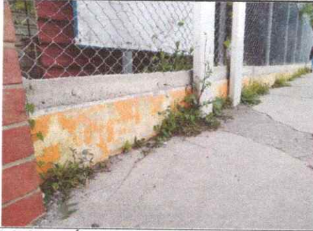
Foto 7: SUSTITUCIÓN DE PINTURA BASE ACEITE (ZOCALO) FRENTE DEL ESTABLECIMIENTO, HACIA MEGAFERRO 75 MTS2
