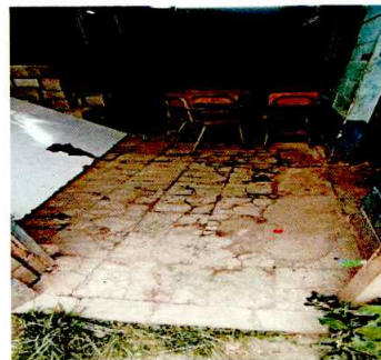
Foto4: FUNDICION DE TORTA RUSTICA EN MODULO DE COCINA
