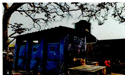
Foto: 6 REALIZACION DE BASE DE METALICA PARA TINACO CON SU INSTALACION DE AGUA POTABLE.
