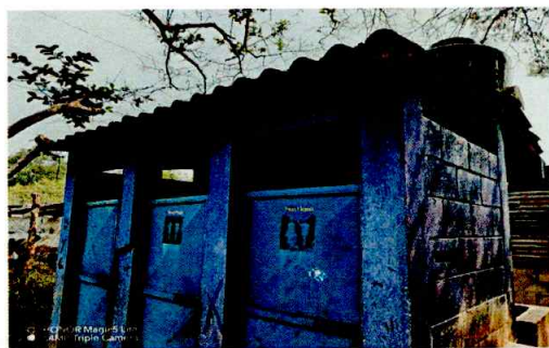
Foto: 5 REMODELACION DE SERVICIOS SANITARIOS, MEJORAMIENTOS A PUERTAS, INSTALACION DE DE AGUA CADA UNO.
