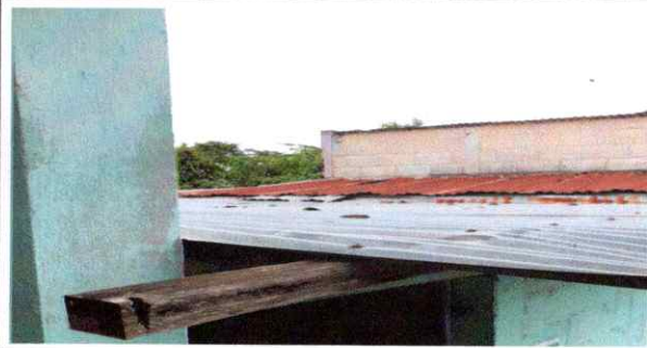
Foto 1: SUSTITUCIÓN DE LAMINA TROQUELADA CALIBRE 26
