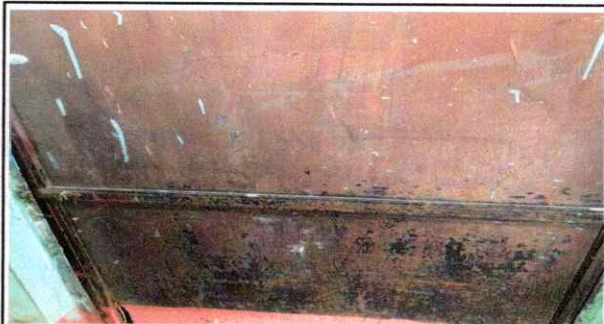
Foto 3: SUSTITUCIÓN DE PUERTAS EN AREA DE AULAS
