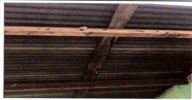
Foto 2: SUSTITUCIÓN ESTRUCTURA DE TECHO
