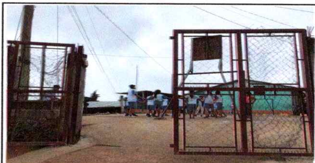
Foto 4: REPARACIÓN Y MANTENIMIENTO A PORTON
