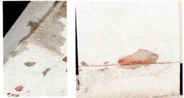
Foto4: Reparación de repello y cernido de paredes
