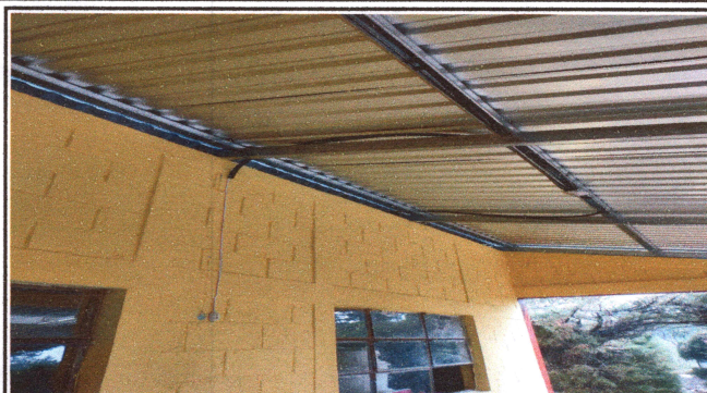
FOTO 2: Suministro y repación de sistema eléctrico
