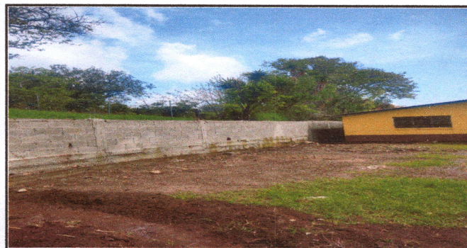
Foto: 5 Reparación de muro de contención
