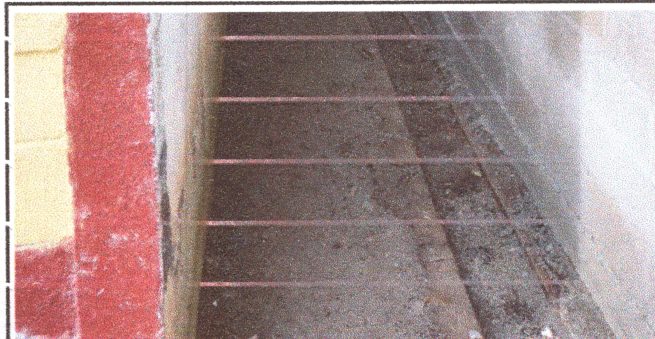
Foto: 6 Mantenimiento y repación de drenajes.
