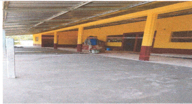
Foto1: Suministro y reparación de losa de patio
