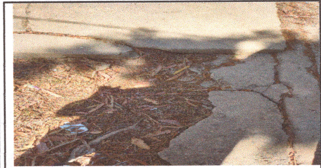
Foto1: Suministro y reparación de losa de patio
