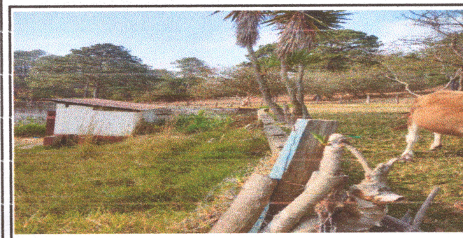
Foto: 5 Reapaación de muro de contención
