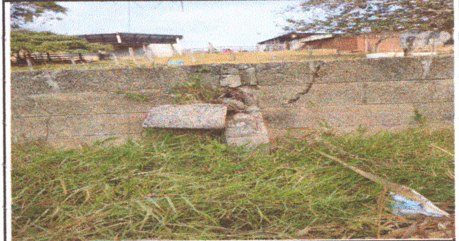
Foto4: suministro y reparación de muro de contención.
