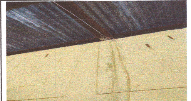
FOTO 2: Suministro y repación de sistema eléctrico
