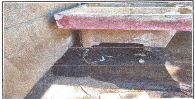
Foto: 6 Mantenimiento y repación de drenajes.
