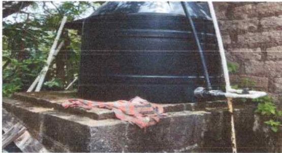
Foto 3: REPARACIÓN, MANTENIMIENTO DE RED DE AGUA POTABLE.
