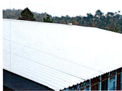
FOTO 2: REPARACIÓN DE TECHO
