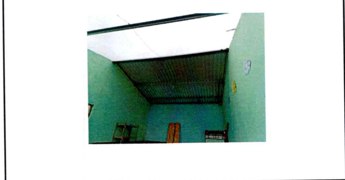
FOTO 2: REPARACIÓN DE TECHO
