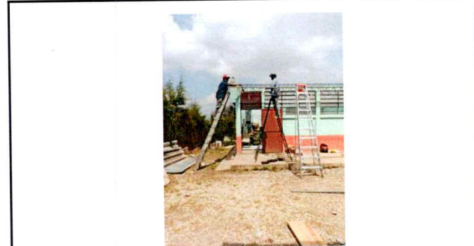
Foto4: REPARACIÓN DE TECHO
