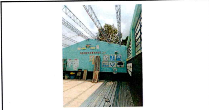
Foto1: REPARACIÓN DE TECHO
