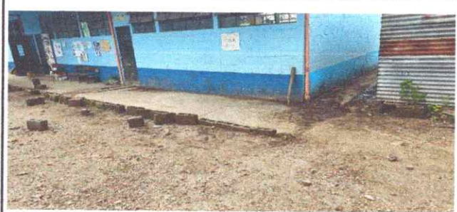
Foto 6: Reparación de Cuneta de concreto.
