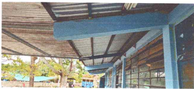
Foto 3: Cambio de estructura metálica.
