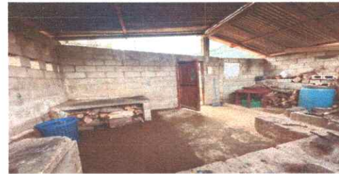
Foto 4: SUSTITUCION DE PISO DE CONCRETO
