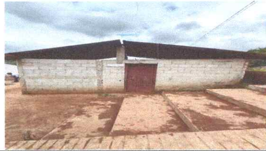
Foto 2: SUSTITUCION DE ESTRUCTURA DE TECHO
