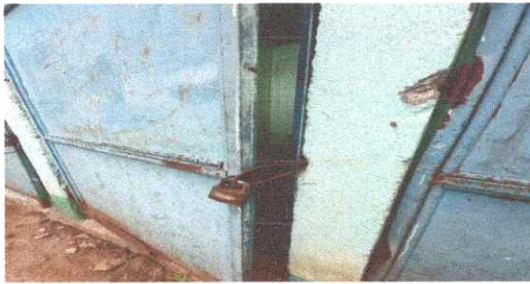
Foto 3: SUSTITUCION DE AREA DE PUERTAS DE BAÑOS
