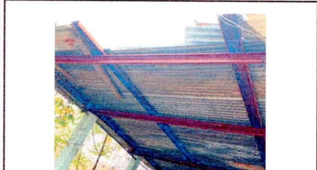
Foto1: Lámina en mal estado. Se observan rajaduras y agujeros.
