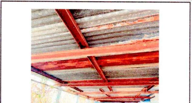
FOTO 2: Estructura metal del techo, deteriorada.
