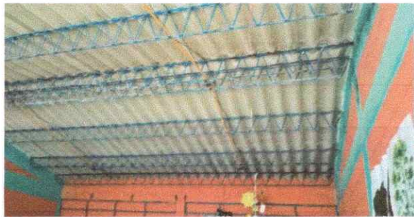
Foto1: SUSTITUCION DE CUBIERTA DE LAMINA (TROQUELADA CALIBRE 26)
