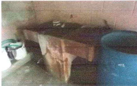
Foto 1: COCINA (sustitucion de pila)
