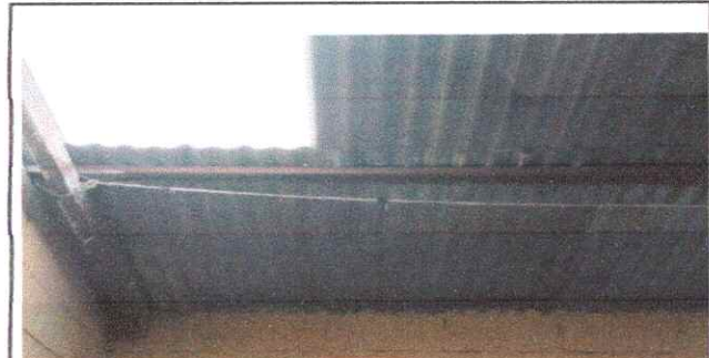
Foto 6: SUSTITUCION DE CABLE CALIBRE 12 MAS DUCTO PVC SOBRE PUESTO
