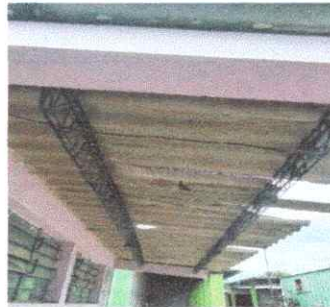
Foto 2: REPARACION DE ESTRUCTURA DE TECHO
