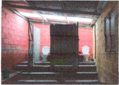
Foto1: REPARACION DE REPELLO Y CERNIDO
