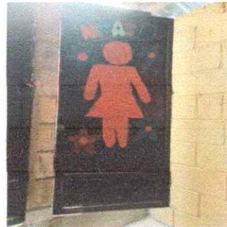
Foto 4: SUSTITUCION DE PUERTA (1.50*0.80mts)
