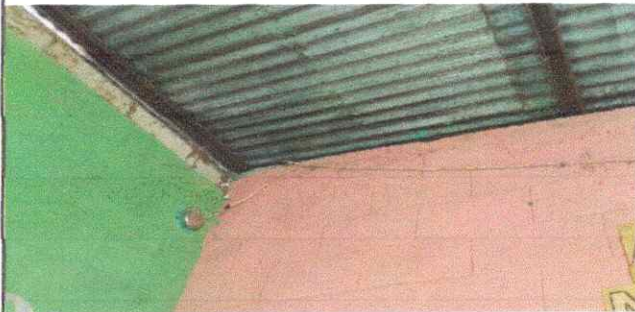
Foto 3: REPARACION DE SISTEMA ELECTRICO (sustitucion de timbre)
