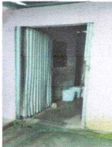
Foto 3: SUSTITUCION DE PUERTA (2*1MTS)
