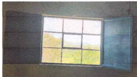
Foto 6: SUSTITUCION VENTANAS (1.25*0.80mts)
