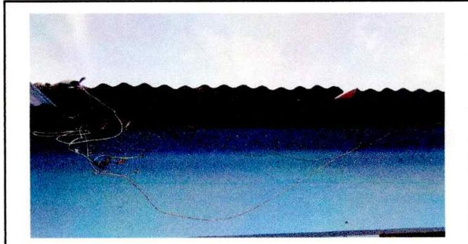
Foto 2: Techo y sistema electrico deteriorado
