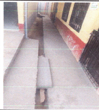
FOTO 2: INSTALACION DE CANALES CON BAJADAS DE AGUA PLUVIAL
