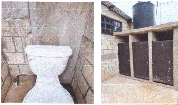
Foto3: REPARACIÓN DE BAÑOS Y REPARACIÓN DE DEPÓSITO DE AGUA
