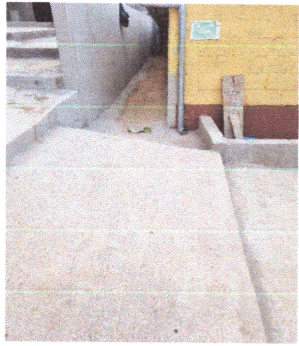
Foto1: LEVANTADO DE MURO
