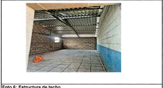
Foto 6: Estructura de techo
