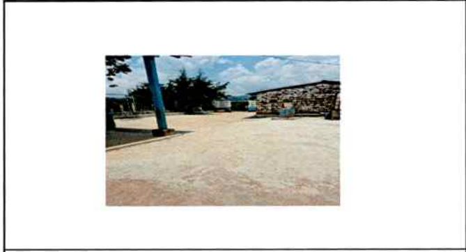
Foto 3: Losa de patio
