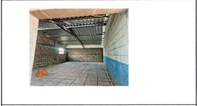
Foto 4: Sustitución de pared
