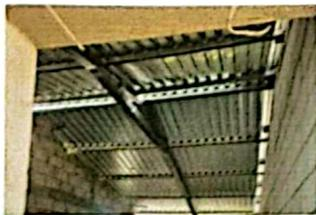
Foto 5: colocación de estructura y lamina
