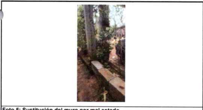
Foto 5: Sustitución del muro por mal estado.
