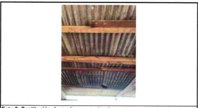
Foto 6: Sustitución de madera por estructura.
