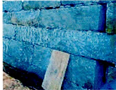
Foto 2: Reparación de muro de contención
