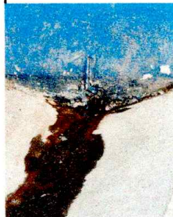
Foto 4: reparación de cuneta de concreto
