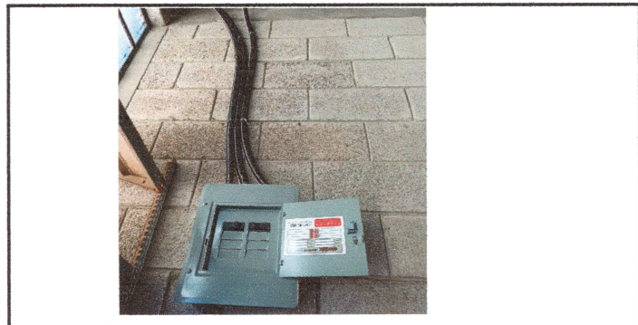
Foto 5: Toda la instalación electrica fue cambiada y también se coloca una nueva caja de filipones.
