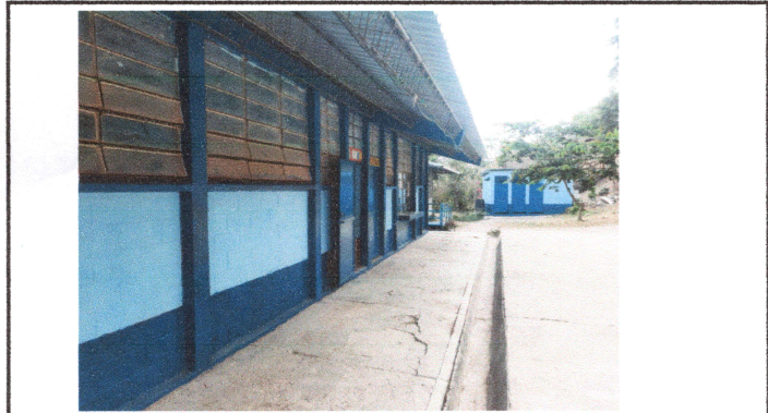
Foto1: El techo cambiado y tambien fueron pintadas las instalaciones de la escuela.
