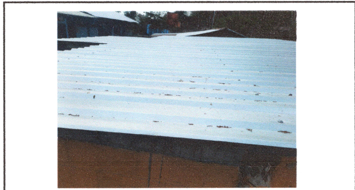
Foto 3: El techa cambiado en tu totalidad
