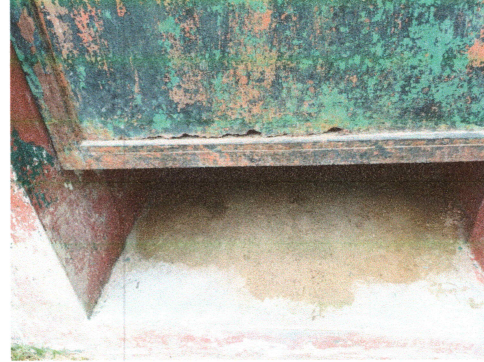
FOTO 2: Se puede observar que las puertas de los baños se encuentran ya picadas y no cierran totalmente
