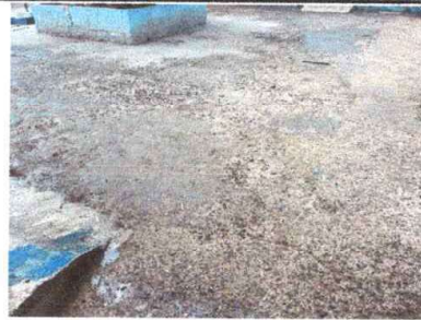
FOTO 2: REPARACIÓN DE PISO
