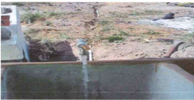
Foto 9: REPARACIÓN DE DRENAJES Y TUBERÍAS DE AGUA.
