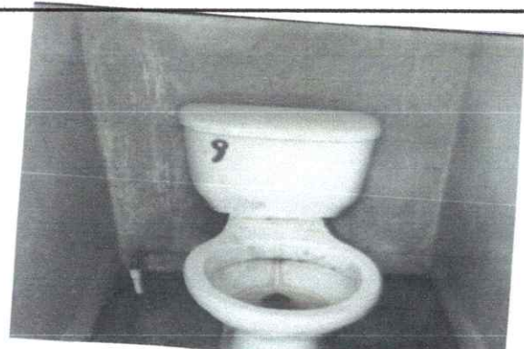
Foto 10: REPARACIÓN, MANTENIMIENTO Y SUSTITUCIÓN DE SANITARIOS.
