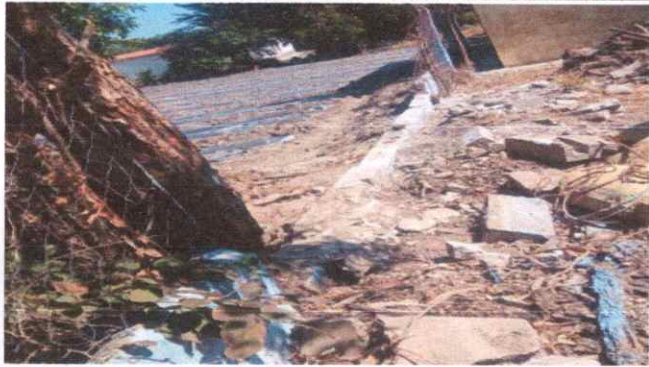
Foto 7: CAMBIO DE MALLA Y REPARACIÓN DE MURO.
