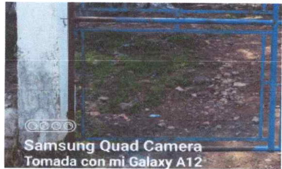
Foto 4: MANTENIMIENTO A PORTÓN..
