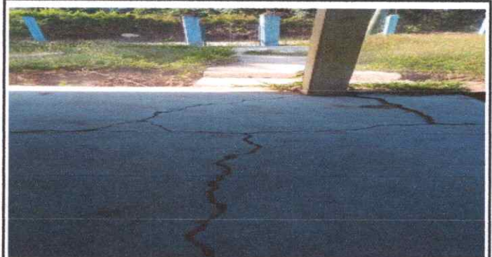
FOTO 8: SUSTITUCIÓN Y MANTENIMIENTO DE BASE Y FUNDICIÓN.
