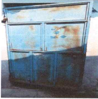
Foto1: REPARACIÓN Y MANTENIMIENTO DE PUERTAS.
