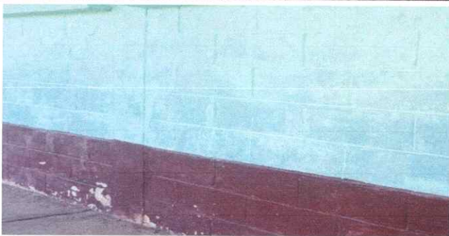
Foto 3: PINTURA EN MUROS INTERIOR Y EXTERIOR.
