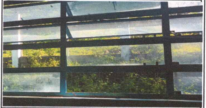
Foto 2: REPARACIÓN LIMPIEZA DE VENTANAS Y VIDRIOS.
