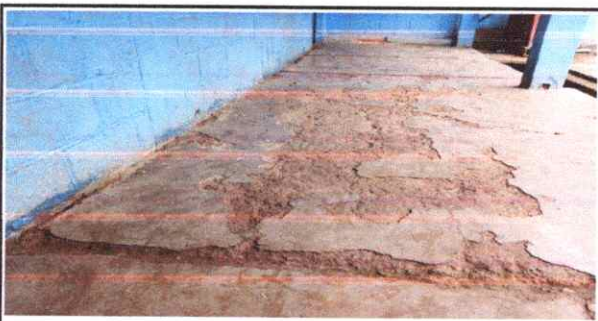
Foto 5: SE OBSERVA LA TORTA LISA DEL CORREDOR DAÑADO
