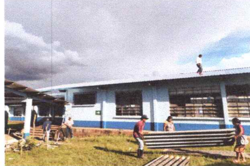
FOTO 2: RETIRO DE MATERIALES PARA LA COLOCACIÓN DE LA NUEVA CUBIERTA
