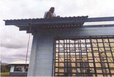
FOTO 5: ASEGURANDO TORNILLOS PARA AFIANZAR NUEVA CUBIERTA
