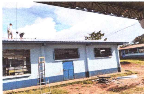
FOTO 6: REVISANDO ALINEACIÓN EN COLOCACION DE CUBIERTA NUEVA.
