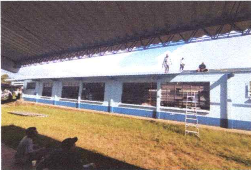
FOTO 3: COLOCACIÓN DE CUBIERTA NUEVA
