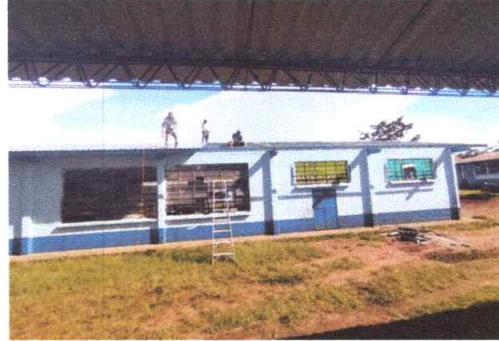
FOTO 4: ATORNILLADO Y ALINEACIÓN DE NUEVA CUBIERTA.
