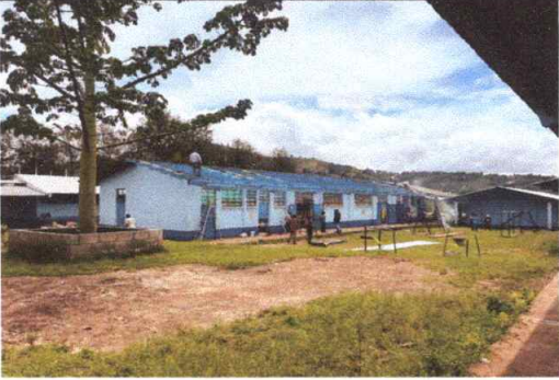
FOTO 1: DESMONTAJE DE CUBIERTA DE DURALITA DETERIORADA
