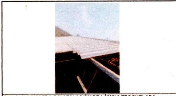
Foto 6: SUMINISTRO E INSTALACIÓN DE LÁMINA TROQUELADA ALUZINC CALIBRE 26
