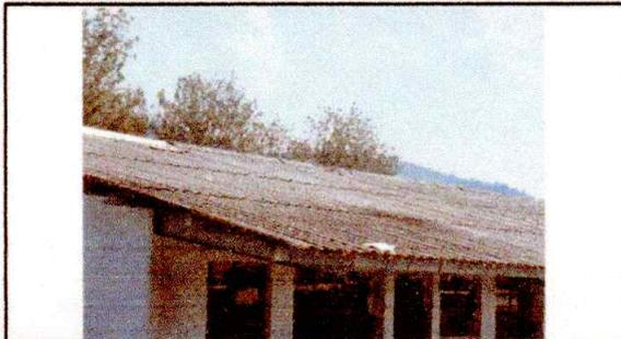
Foto1: SUMINISTRO E INSTALACIÓN DE LÁMINA TROQUELADA ALUZINC CALIBRE 26
