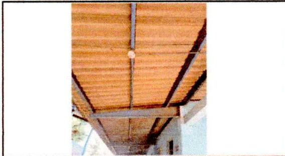
Foto 4: SUMINISTRO E INSTALACIÓN DE LÁMINA TROQUELADA ALUZINC CALIBRE 26
