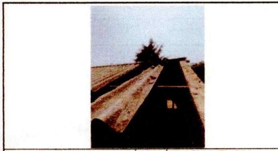
Foto 5: SUMINISTRO E INSTALACIÓN DE LÁMINA TROQUELADA ALUZINC CALIBRE 26
