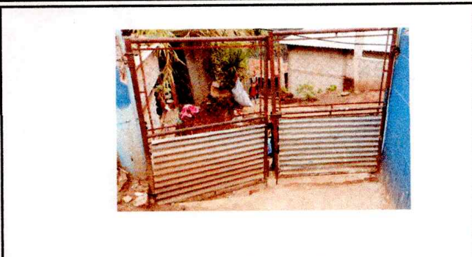
Foto 1: MANTENIMIENTO O CAMBIO DE PORTON
