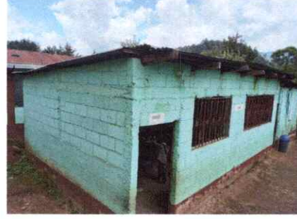
Foto 2: ESTRUCTURA DE TECHO
