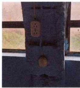
Foto 5: SUSTITUCION DE INTERRUPTORES SIMPLES (incluye cableado)
