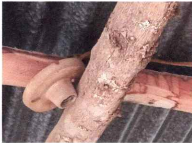
Foto 3: SUSTITUCION DE LAMPARAS LED
