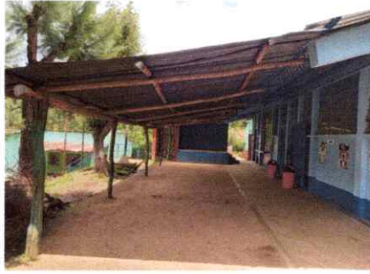
Foto1: CUBIERTA DE LAMINA
