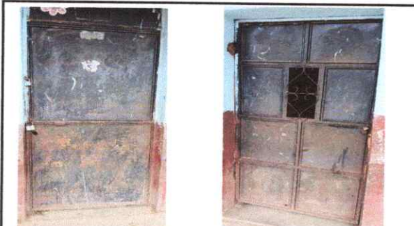
Foto 3: Reparación y Mantenimiento de puertas de las aulas.
