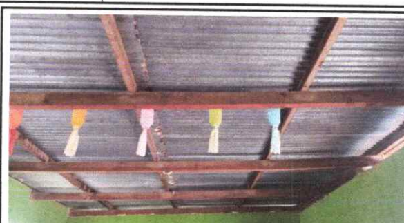
Foto 2: Cambio de estructura de techo por deterioro.
