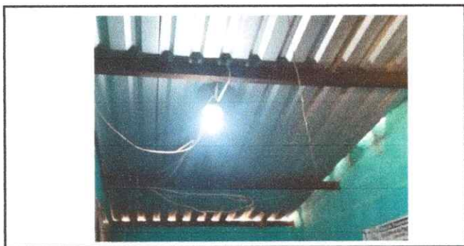
Foto 6: INSTALACION DE LAMPARAS E INTERRUPTOR (incluye cableado)
