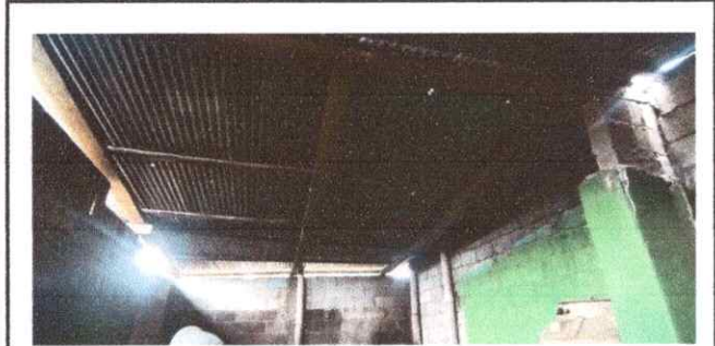
Foto 1: SUSTITUCION DE LAMINA Y ESTRUCTURA DE COCINA
