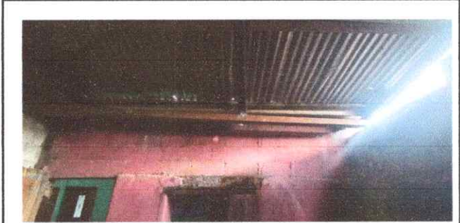
Foto 2: SUSTITUCION DE LAMINA Y ESTRUCTURA DE AULA
