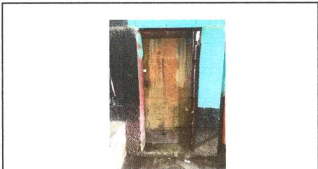
Foto 4: SUSTITUCION DE PUERTA (1.90*0.85 MTS)
