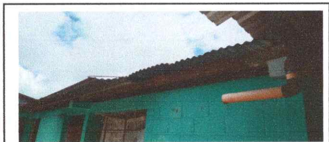
Foto 3: SUSTITUCION DE CANAL DE METAL (CALIBRE 26)
