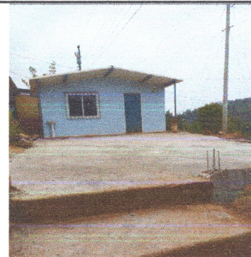
Foto 6: FINALIZACIÓN DE TORTA DE CEMENTO EN PATIO..
