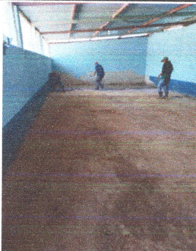
Foto 3: SUSTITUCIÓN DE TORTA DE CEMENTO EN SALÓN DE CLASES.
