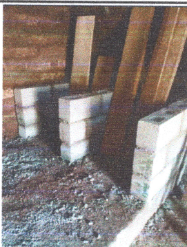
Foto 5: REMODELACIÓN DE ESTUFA RURAL EN ÁREA DE COCINA.
