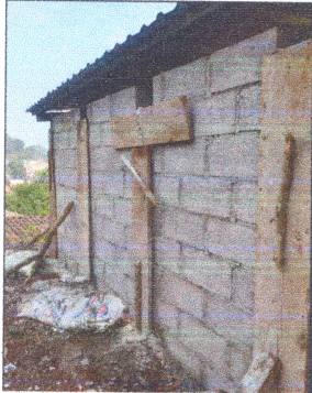
Foto 1: PROCESO DE REPACIÓN DE PARED EN SERVICIOS SANITARIOS.
