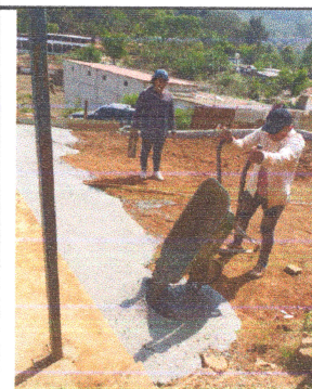
Foto 6: SUSTITUCIÓN DE TORTA DE CEMENTO EN PATIO.
