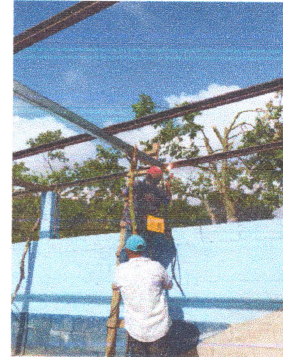
Foto 2: INSTALACIÓN DE TECHO O CUBIERTA EN SALÓN DE CLASES.
