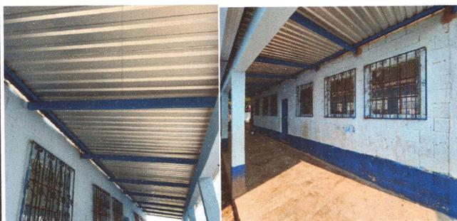
Foto 2: Cambio de Estructura de Techo
