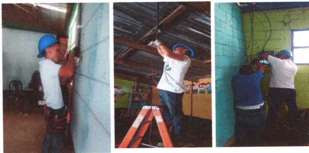
Foto 5: Reparación de Sistema Eléctrico
