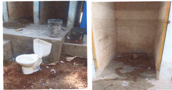
Foto 4: Reparación de servicios sanitario y sus accesorios
