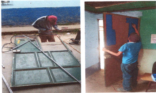
Foto 3: Reparación de Puertas
