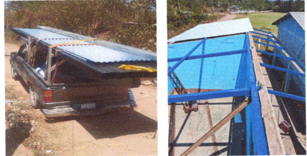
Foto 2: Cambio de Estructura de Techo
