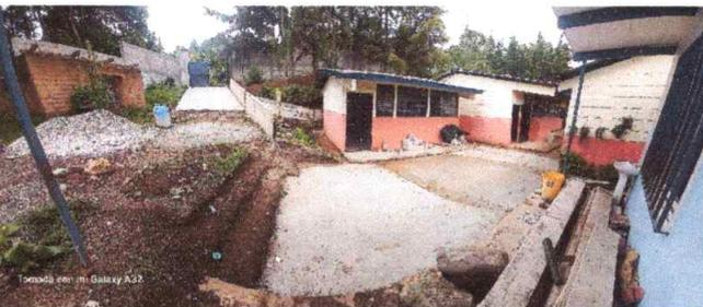
Foto: 5 Se observa el avance de la extracción y sustitución de losa de patio.
