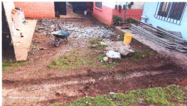
Foto 3: Se observa la extracción de la losa en mal estado.
