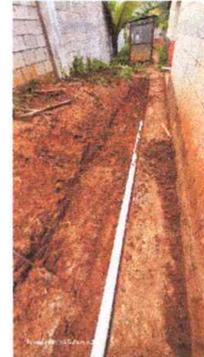
FOTO 2: Se observa el avance de la reparación de drenajes.
