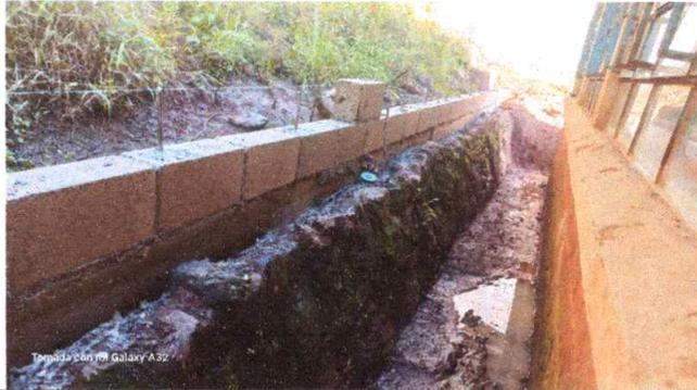
Foto1: se observa el refuerzo que se le está haciendo al muro de contención.
