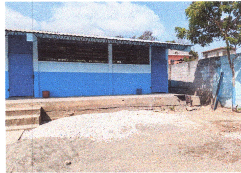
FOTO 2: Pintado de Paredes
