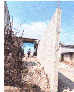
Foto 6: Reparación de muro perimetral
