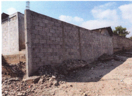
Foto 5: Reparación de muro perimetral
