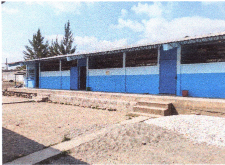
Foto1: Pintado de paredes
