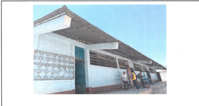
Foto1: Pintado de paredes
