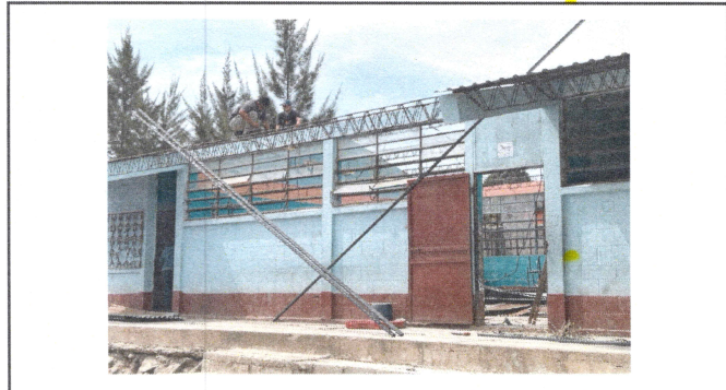
FOTO 2: Pintado de Paredes
