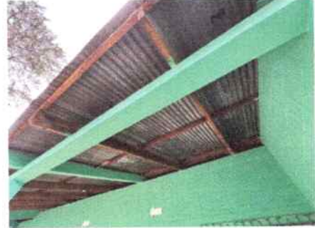
FOTO 2: REPARACIÓN DE ESTRUCTURA DE TECHO
