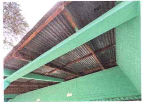
Foto: 6 SUSTITUCIÓN DE ESTRUCTURA PARA TECHO
