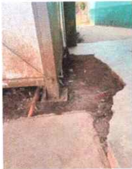
Foto: 5 REPARACIÓN LOSA EN PATIO
